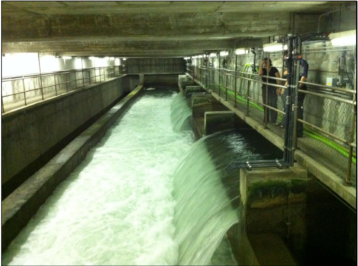
Canal de mise en charge de l'eau brute
