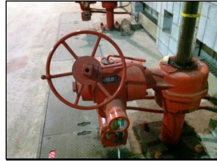
Vanne d'entrée de l'eau brute
