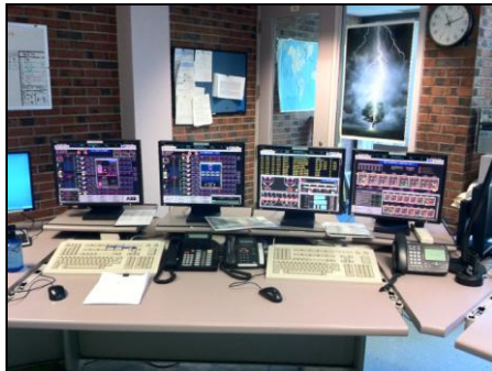
Salle de commande des eaux
