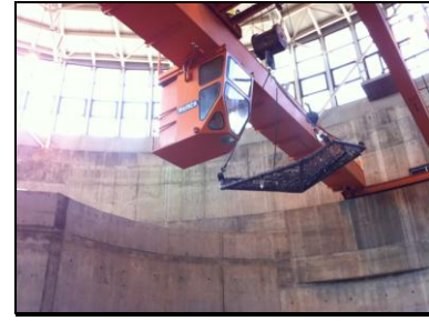
Pont roulant pour écumer le dessus des puits de succion
