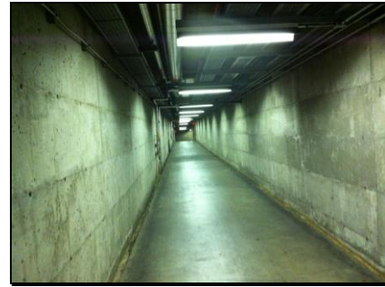
Galerie souterraine de l'usine d'épuration
