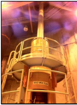
Pompe de puits de succion
