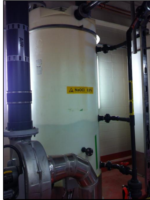
Réservoir intermédiaire d'hypochlorite de sodium à 0,8 %
