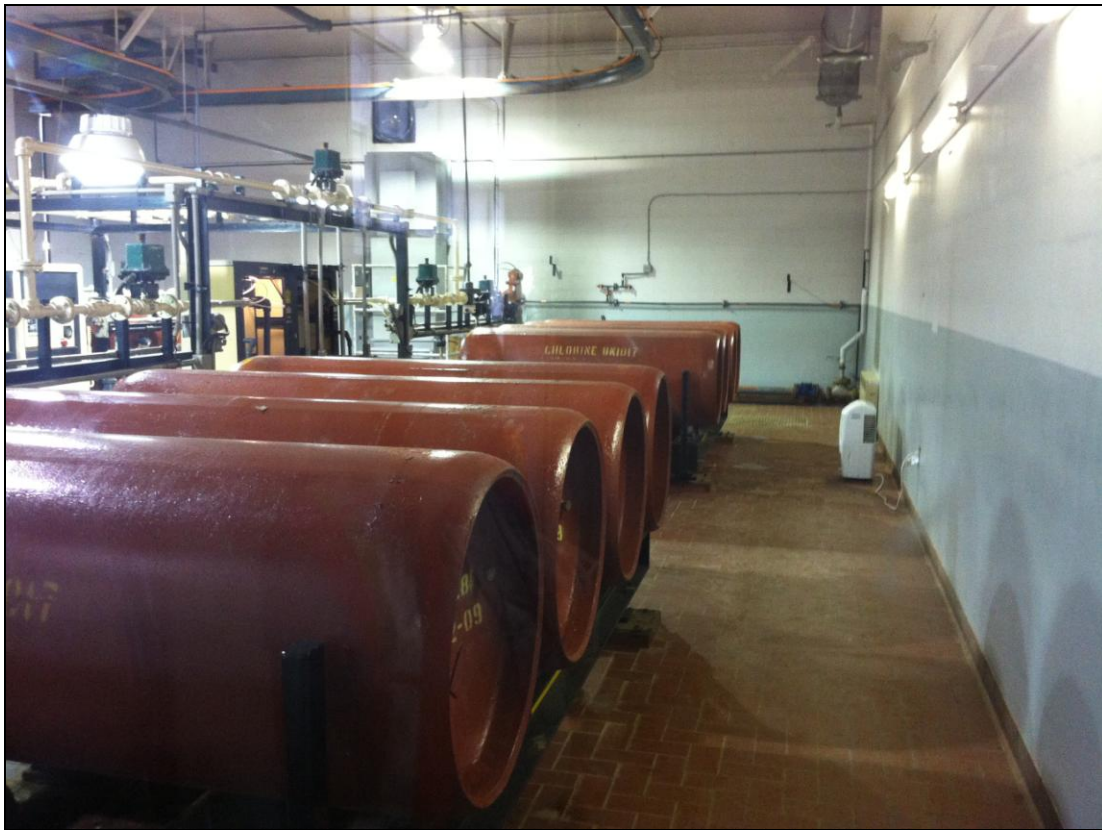
Salle des chlorateurs et des bombonnes de chlore à l'usine Atwater
