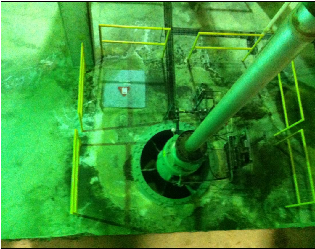
L'arbre d'une pompe d'eau brute
