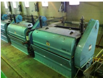
Tamis utilisés pour l'eau du Canal de l'Aqueduc
